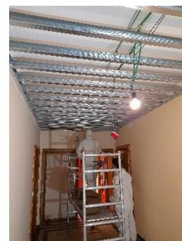
En ce début 2023, les changements deviennent très sensibles à l'intérieur du bâtiment : cloisonnement des deux cages d'escalier accessibles au public et compartimentage des diverses ailes du bâtiment, nouvelle sortie de secours dans le grand auditoire, isolation des plafonds sous grenier (cela concerne les
